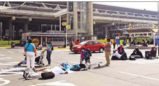
Los severos daños del aeropuerto provocó que los pasajeros que debían volar a diversos destinos salieran del recinto y se ubicaran en los estacionamientos. Finalmente, los despegues y aterrizajes fueron suspendidos.
