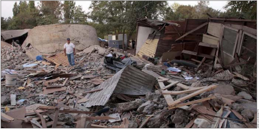
TRAGEDIA.— El silo tenía daños desde el terremoto de 1985, que lo dejó con una leve inclinación sobre las casas que se encontraban justo abajo. En la foto, los escombros de la tragedia.
