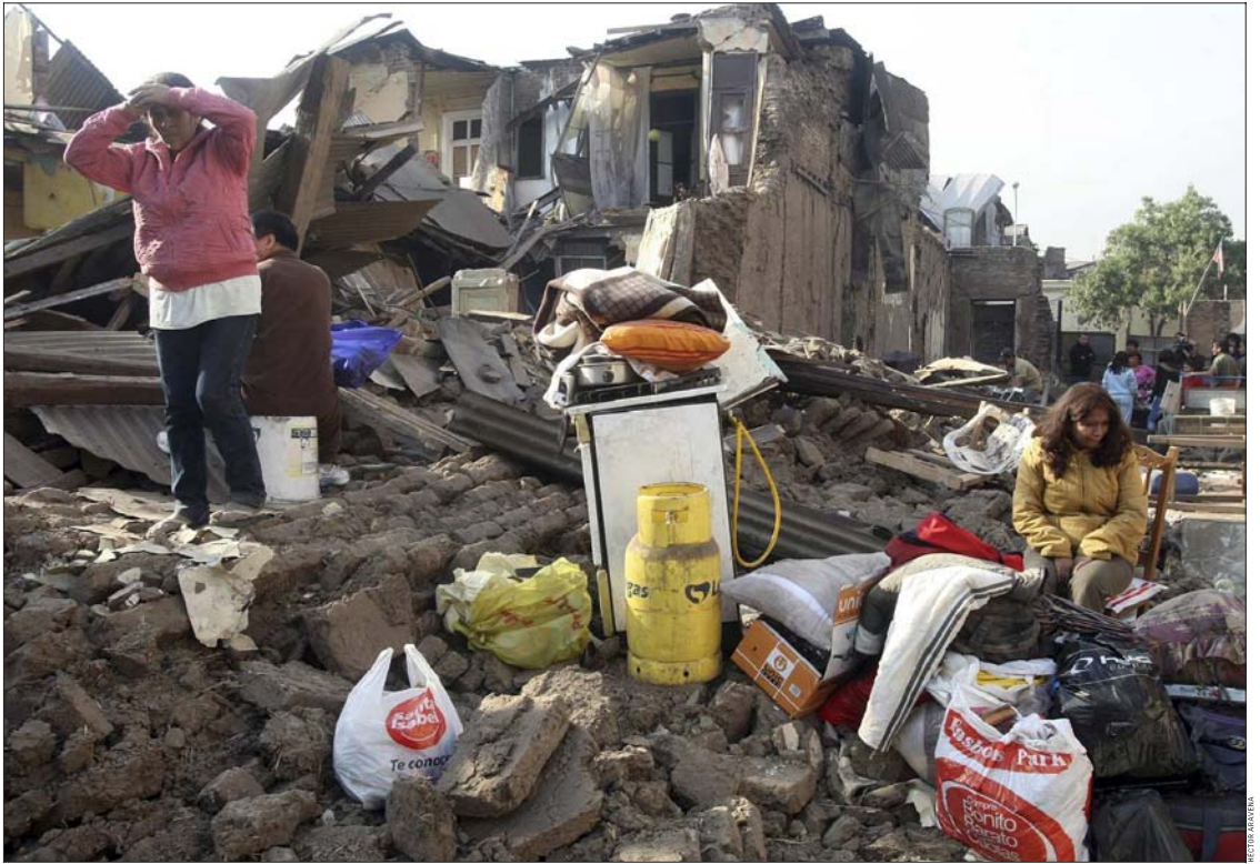
SANTIAGO CENTRO.—El sector del Barrio Brasil sufrió los efectos del devastador terremoto. En la imagen, casas destruidas en el sector de calles Santo Domingo y Ricardo Cumming.
