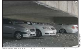
INUTILIZADOS.—Más de 50 vehículos sufrieron daños totales tras ser sepultados por el nivel superior.
