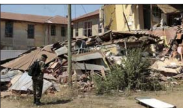
DAÑOS.— El 70% del recinto asistencial fue destruido y sólo un tercio de las camas quedaron disponibles para otros pacientes.
