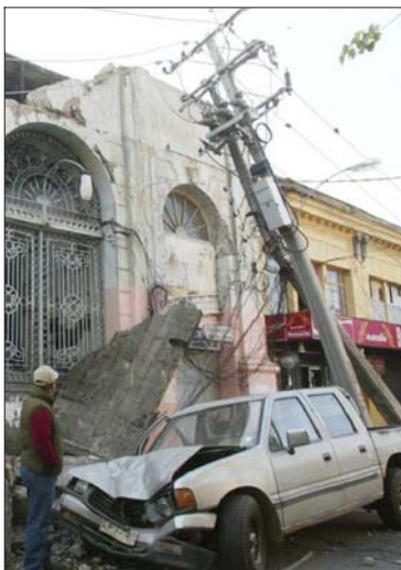
El mercado de Talca fue otro de los inmuebles que sufrió graves daños.
