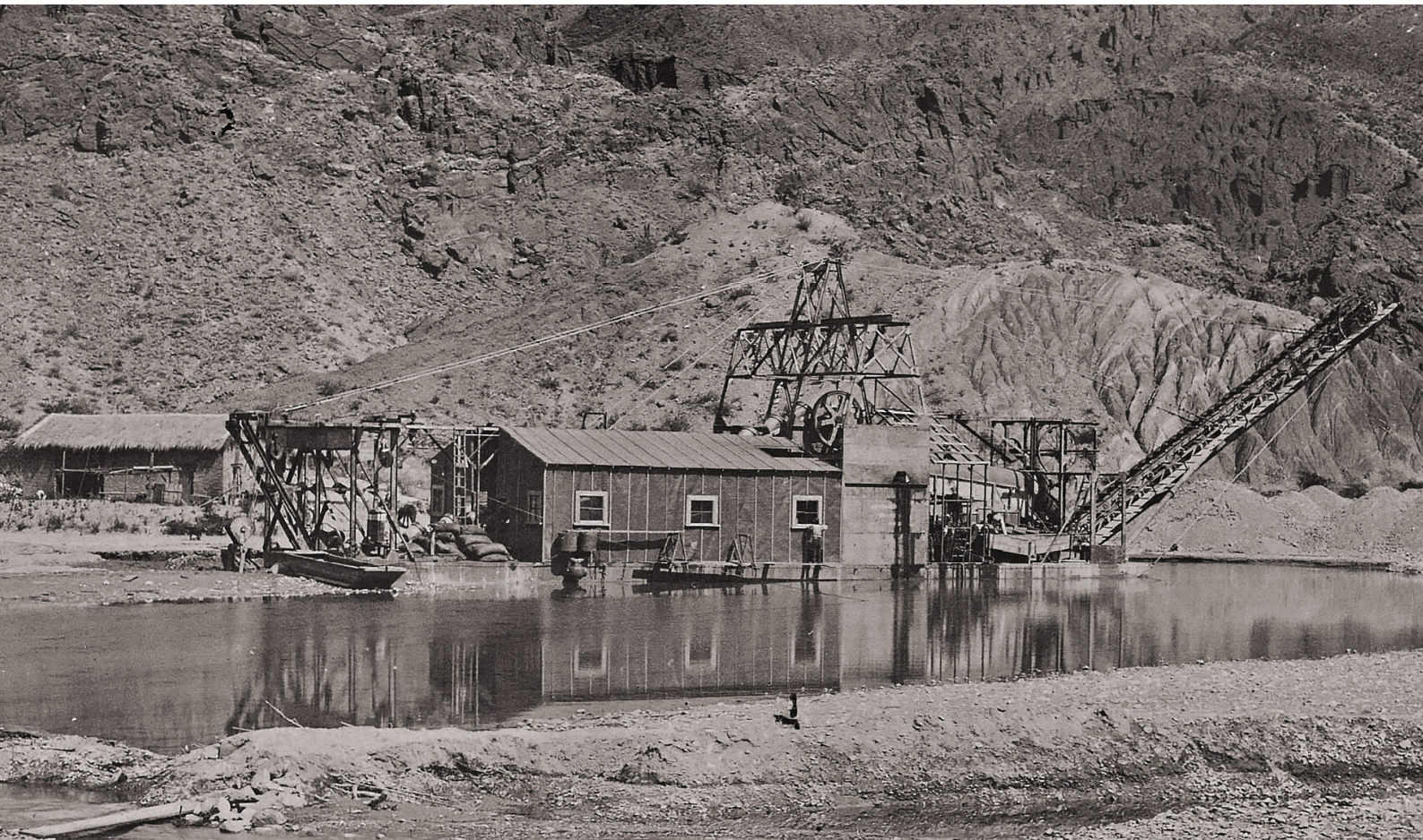
Detalle de la panorámica arriba. Se trata de la misma draga que aparece en construcción en la imagen de página 2, pero vista aquí desde el lado opuesto.
