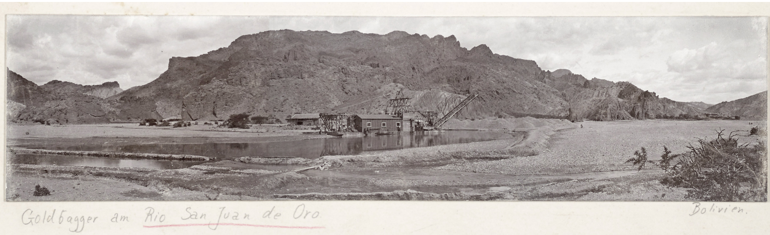
Draga fluvial en Espicaya, sede de la Segunda Compañía San Juan de Oro, a fines de 1905
