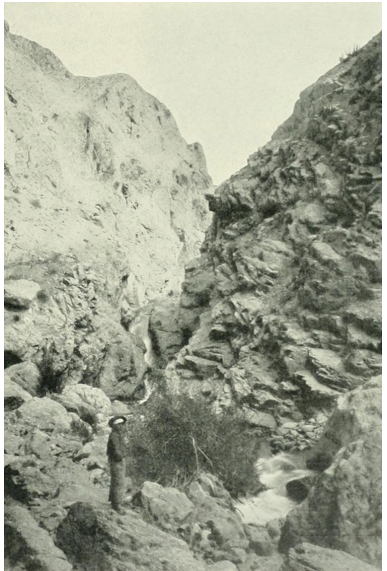
CASCADA EN LA LÍNEA PROYECTADA DEL FERROCARRIL DE ARICA A LA PAZ
